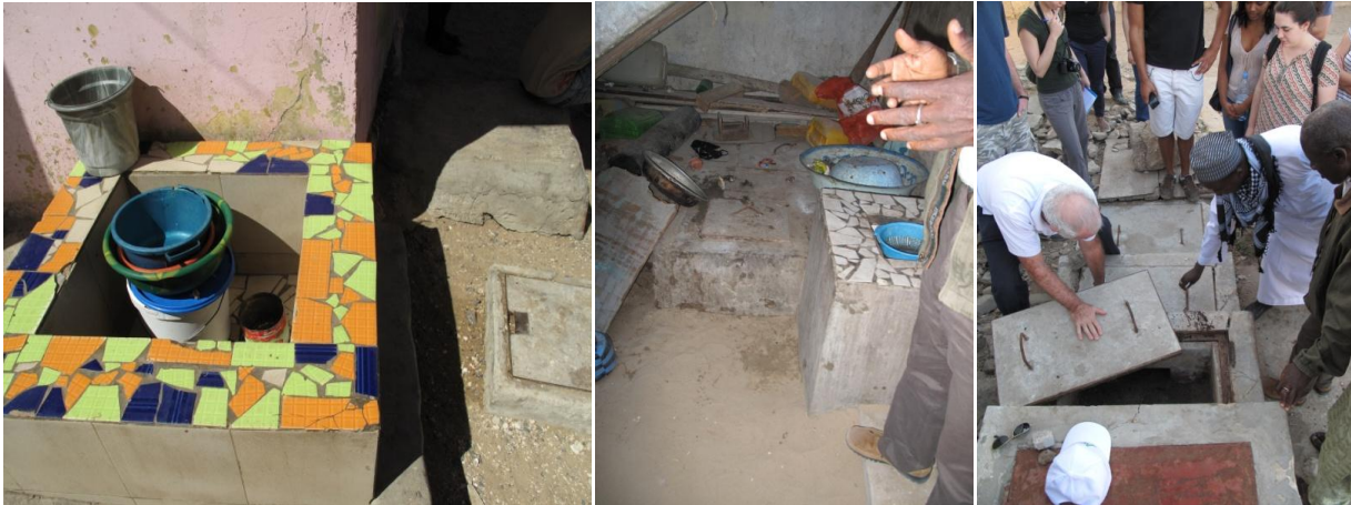
Différentes solutions pour le recueil des eaux grises : vidoir domestique extérieur à Ngor, Vidoir domestique intérieur avec filtre « passoir » à Yoff-Tonghor, vidoir collectif à Yoff-Tonghor (HS)
