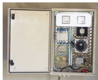
Afin d'assurer la pérennité du réseau, on doit s'assurer d'un fonctionnement permanent du dispositif de soutirage de courant. Un relevé des indications numériques des appareils de mesure (voltmètre, ampèremètre, compteur d'énergie) doit être fait une fois par mois. Le câble de la canalisation doit toujours être connecté au pôle – du redresseur, le câble des anodes au pôle + du redresseur.
