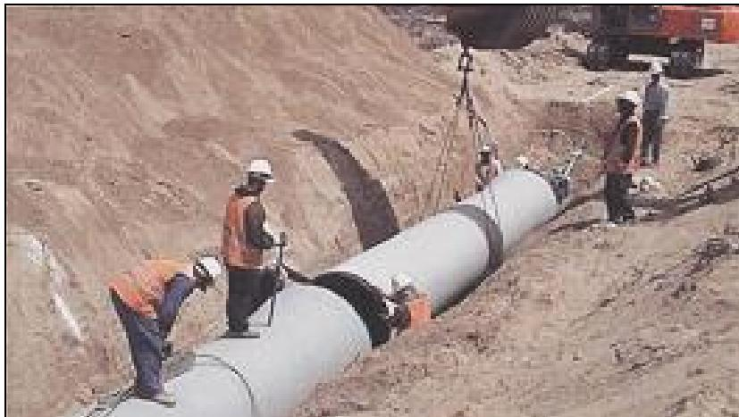
Le tuyau sera nettoyé de l'intérieur, des cailloux et des débris, avant de le présenter concentriquement devant le dernier posé. Les deux bouts seront rapprochés avec un, deux ou trois Tirfor, selon les diamètres, jusqu'à ce que l'emboîtement atteigne la marque précisée sur le tuyau.
