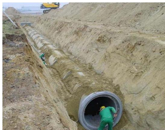
Aménagement qui consiste à donner aux parois une倾inéation qu'on appelle angle de talus et qui permet d'assurer la stabilité, sans risque d'éboulement. Cet angle est proche de l'angle  $\phi$  de frottement intérieur du terrain qui dépend de la nature du terrain traversé.
