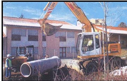
La précontrainte longitudinale résiste aux efforts de flexion et permet au tuyau de résister aux efforts du frettage.
