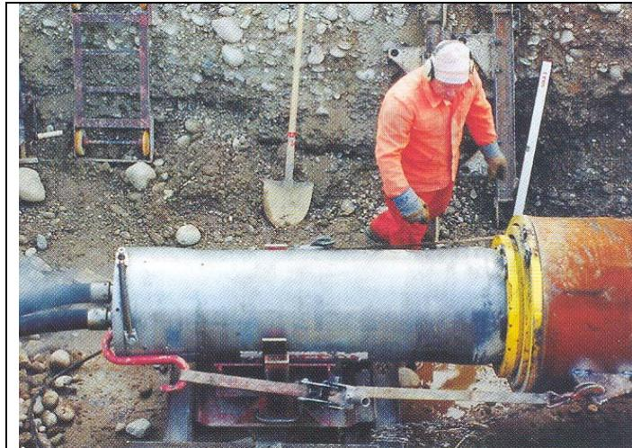
Les écarts en plan et en altitude de l'axe du tuyau à l'axe théorique seront fixés au préalable. Les travaux sont conduits de manière qu'aucune poussée soit exercée sur les canalisations ou ouvrages existants.
