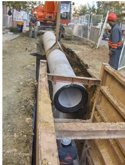
Les éléments d'une canalisation forment une chaîne où tous les maillons comptent : un seul élément mal posé, un seul joint défectueux est préjudiciable à la qualité de la conduite entière. L'assemblage des conduites consiste en la mise en œuvre des joints entre éléments du réseau pour assurer l'étanchéité aux conditions de service prévues, y compris en régime transitoire (pression, dépression).
