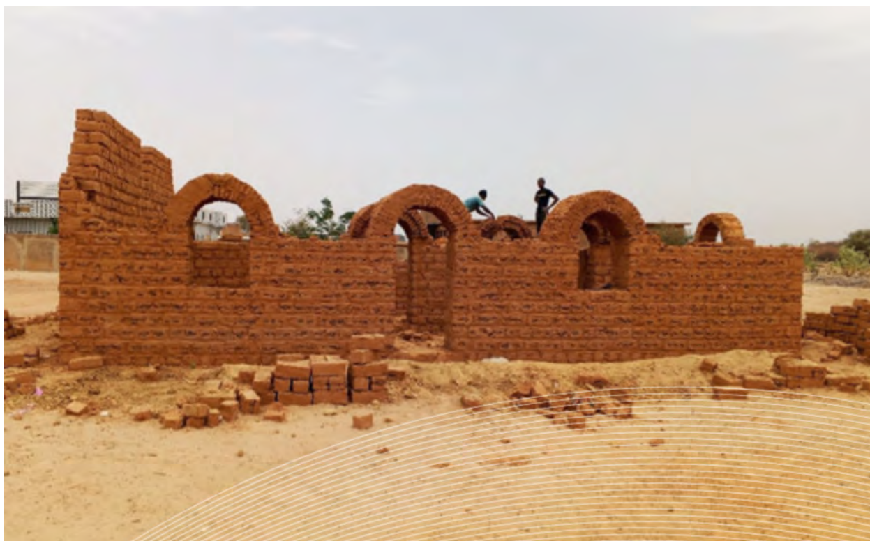
Voûte nubienne en construction. © ADSCAL
