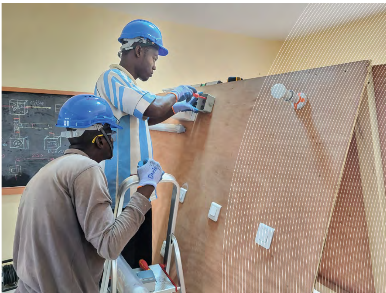
Élèves réalisant une installation intérieure. © ESF
