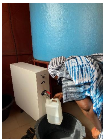
Citerne de 1 000 L + outil de potabilisation : filtre + lampe à UV
