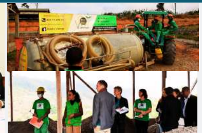
Visite du site de traitement des boues des vidanges de la commune urbaine de Fianarantsoa
