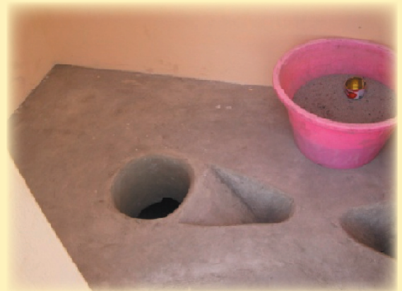
Cuvette de latrines ECOSAN
