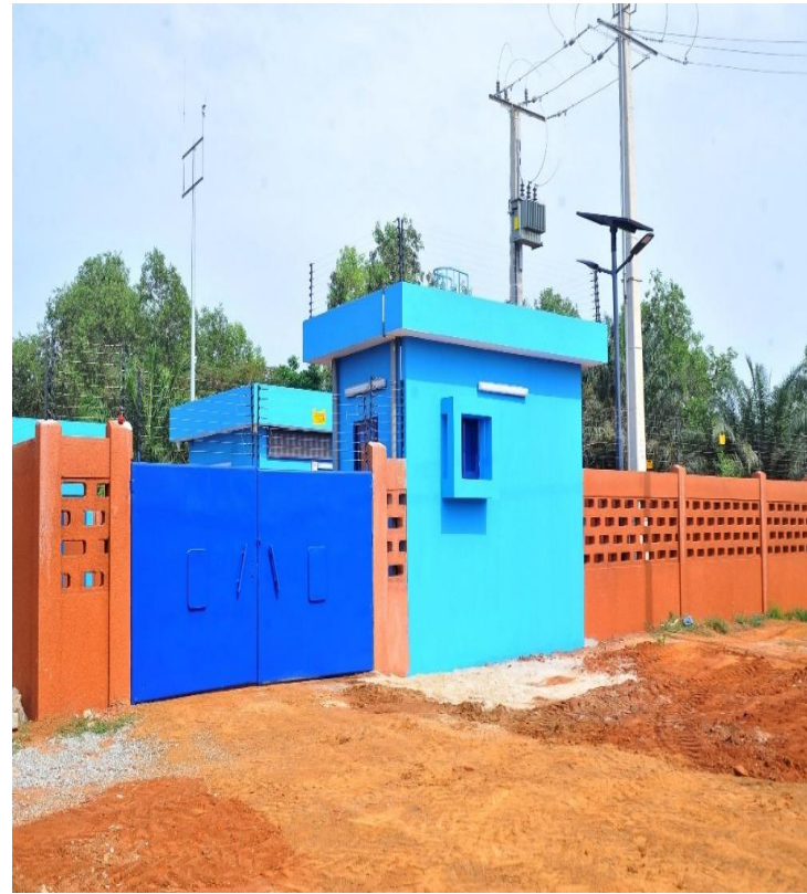
Tours de dégazage, château d'eau (1 750 m 3 ) et salle de traitement à Gbènan/Ouidah
