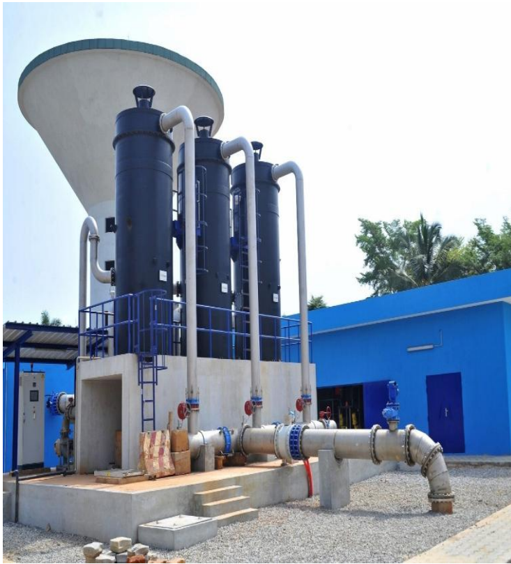
Nouveau site de forage aménagé à Ouidah
