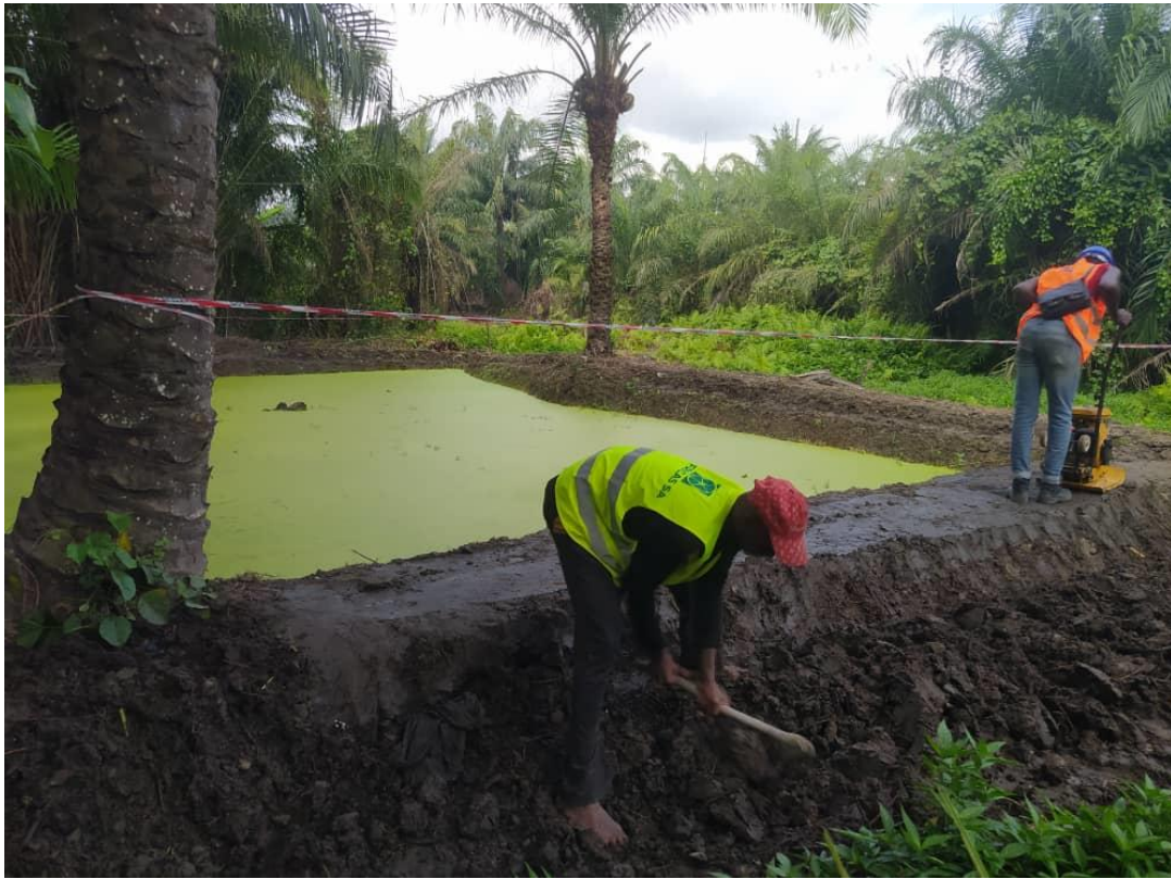
Travaux de construction des étangs piscicoles à Kpota (Lokossa)
