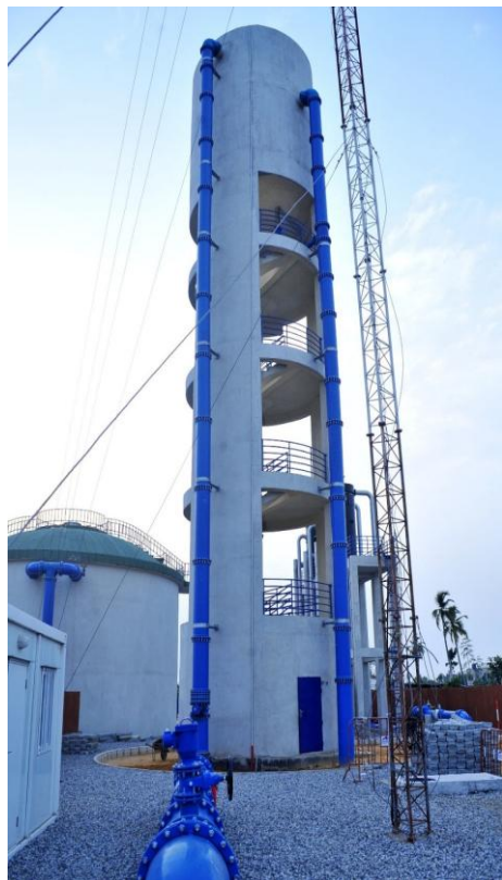
Château d'eau et tour de dégazage de la station de Sèmè- Kpodji
