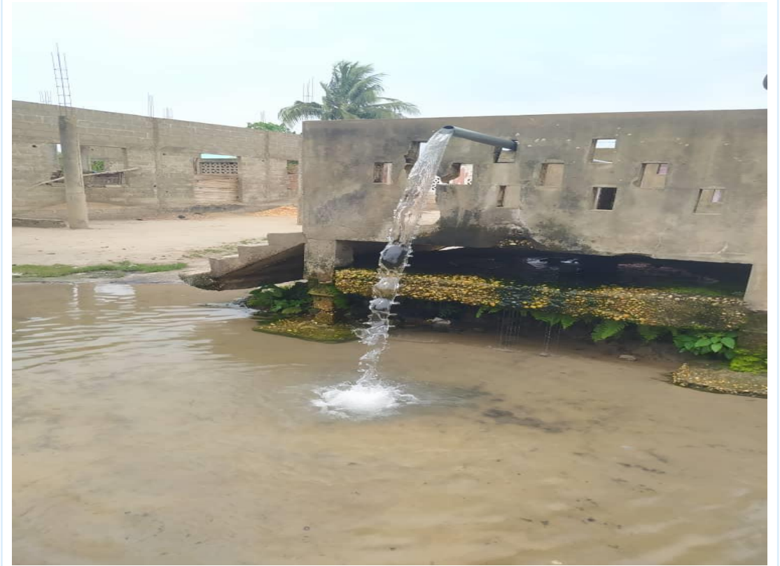
Forage artésien à Zoumè (Lokossa)
