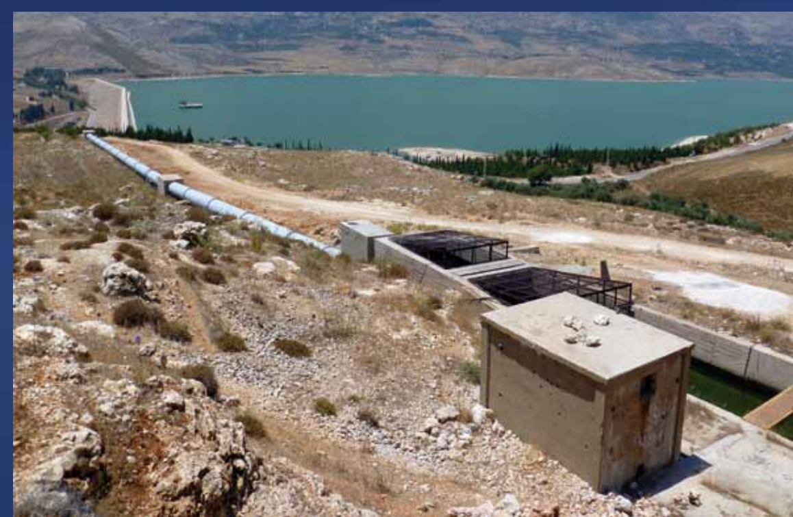
Le barrage régule le débit des rivières et les alimente en période sèche, grâce aux stocks d'eau de la retenue. Prise d'eau pour un canal d'irrigation au Liban.
