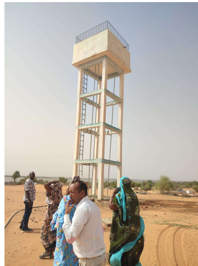
Château d'eau - Mauritanie
