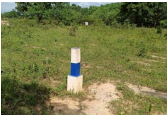
Installation des balises de délimitation des francs bords
