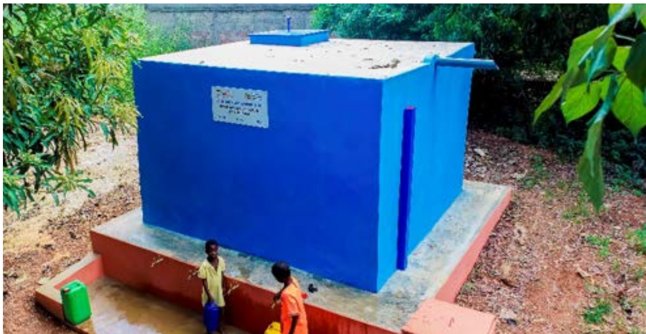
Cuve aménagée du forage artésien de Tchirmina à Natitingou
