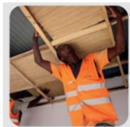
Pose isolant fibres (typha ou jonc) et faux-plafond (contreplaqué)
