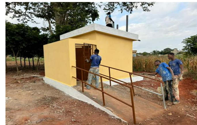
Nouvelle latrine construite dans une école à Zio 2
