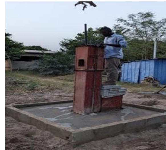
Une BF en construction
