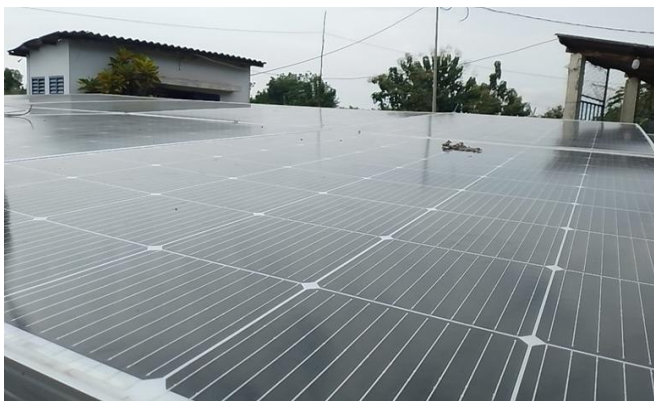
Installation du système solaire sur le F1
