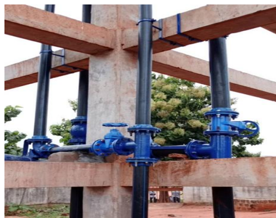
Réhabilitation du château de Zio 2
