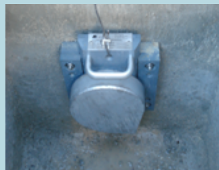
Régulateur à effet siphon avec rail de positionnement
