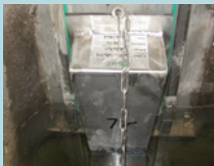
Régulateur à effet siphon avec chaîne d'extraction
