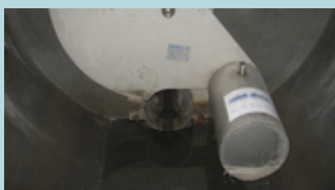
Régulateur de débit à flotteur
