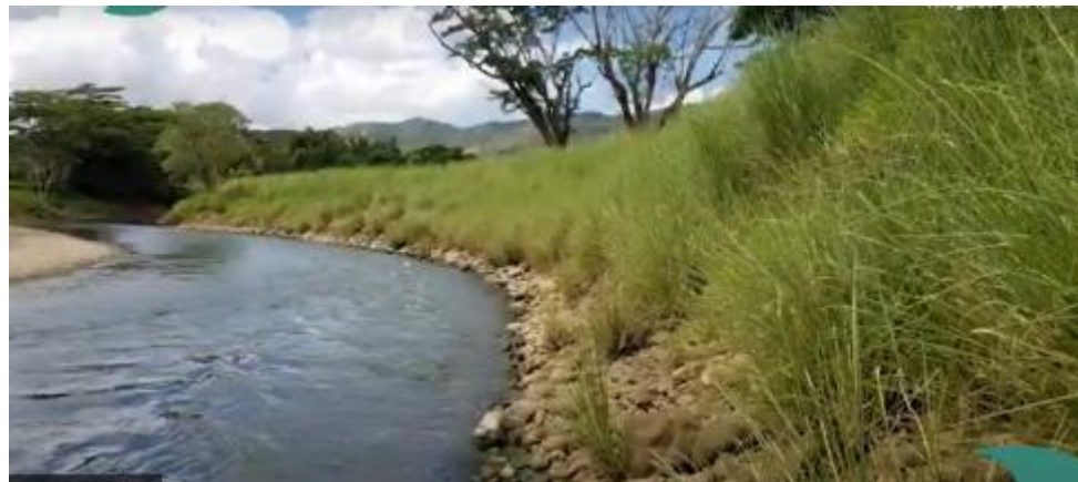
Restauration des berges de la rivière Néra – Nouvelle-Calédonie
