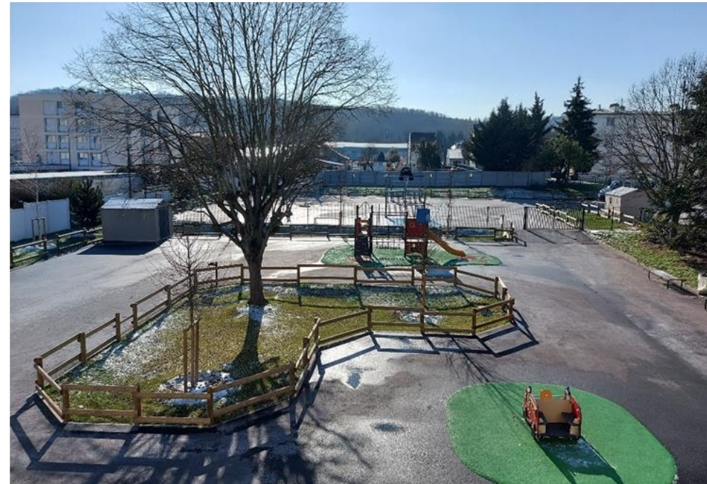
Espaces verts en creux et noues (Ecole Gambetta, Sannois) Source : Association Espaces
